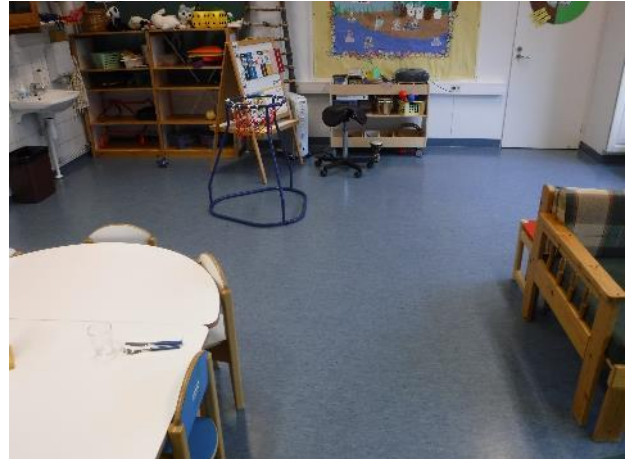
Kuva 22. Alkuperäisen osan lattiapinnoitteet ovat hyvässä kunnossa. Pinnoitteet on uusittu vuoden 2003 remontin yhteydessä.
