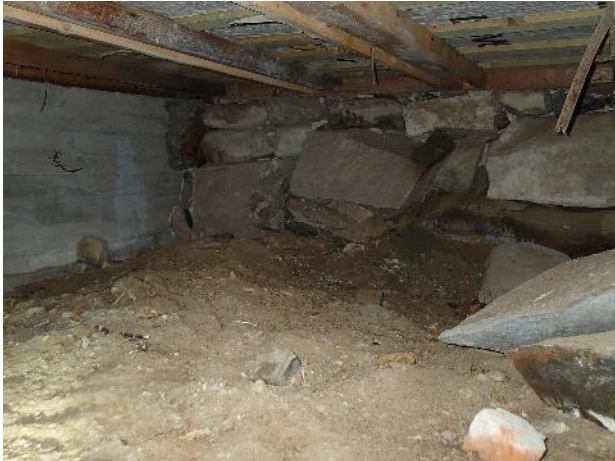
Kuva 13. Alkuperäisen rakennuksen rossitila on puhdistettu alapohjarakenteen uusimisen yhteydessä.
