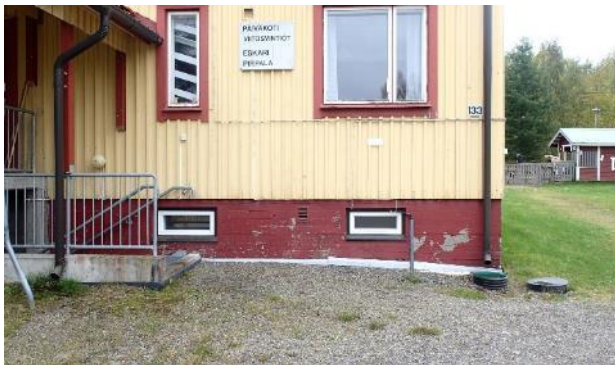
Kuva 7. Rakennuksen koillis-, luoteis- ja lounassivuille on asennettu salaojajärjestelmät ja perusmuurilevytyt
