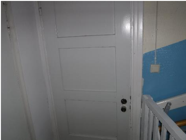
Kuva 19. Väliovet ovat paikoin uusittuja ja paikoin alkuperäisiä. Väliovissa on ajantuumaa kulumista.
