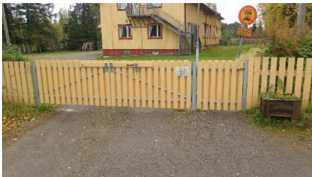
Kuva 3. Uuden aidan runkorakenteet ovat teräksiset ja verhoilu on maalattua puuta.
