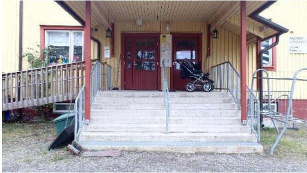
Kuva 5. Uusitut porras- ja ramppirakenteet ovat hyväkuntoiset
