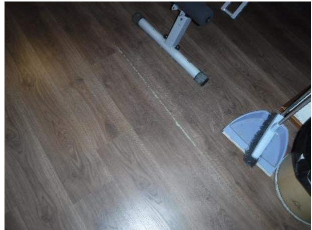
Kuva 20. Kellarin kuntosalin lattian laminaatti oli tyydyttävässä kunnossa. Ajan- ja käytöstä aiheutuneita kulumisen jälkiä.
