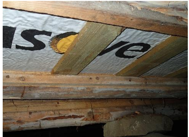
Kuva 12. Alkuperäisen rakennuksen tuulettuva alapohjarakenne on uusittu. Vanhoissa puuosissa oli jonkun verran vanhoja vauriojälkiä.
